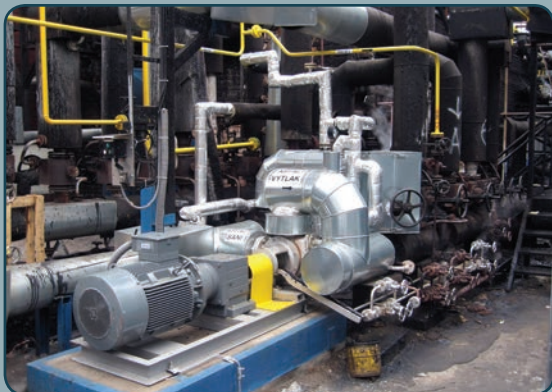
PARAMO a.s., ASFALT, НАСОСЫ ТИПА MV С ОБОГРЕВОМ КОЖУХА
