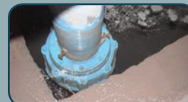
U.S. STEEL KOŠICE s.r.o., АБРАЗИВНАЯ ЖИДКОСТЬ, НАСОСНЫЙ АГРЕГАТ ТИПА CSX – V CANTILEVER
