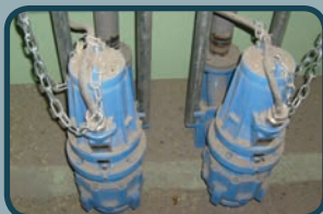
TŘINECKÉ ŽELEZÁRNY a.s., ЦЕХ Kladno ВОДА С ОКАЛИНОЙ, НАСОСЫ ТИПА CSX – S
