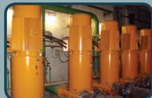
TŘINECKÉ ŽELEZÁRNY a.s., ОХЛАЖДЕНИЕ ТЕРМЕКС, АГРЕГАТЫ ТИПА CSN С ЭЛЕКТРОДВИГАТЕЛЕМ 200 KW С ПРЕОБРАЗОВАТЕЛЕМ ЧАСТОТЫ
