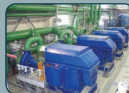
ИЖОРСКИЙ ЗАВОД [РОССИЯ], ОХЛАЖДАЮЩАЯ СЕТЬ, АГРЕГАТЫ ТИПА CSE С ЭЛЕКТРОДВИГАТЕЛЕМ 315 KW, 6000 V
