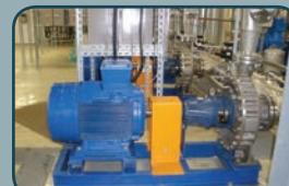
DIAKO S.P., ОБРАБОТКА МАТЧЕНЫХ ЛУГОВ, НАСОСНЫЕ АГРЕГАТЫ ТИПА CSA
