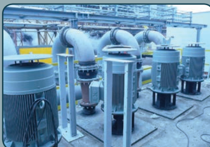
PREOL a.s., ЦЕНТР ОХЛАЖДЕНИЯ, НАСОСНЫЕ АГРЕГАТЫ ТИПА CSEV – ВЕРТИКАЛЬНОЕ, ИСПОЛНЕНИЕ С ЭЛЕКТРОДВИГАТЕЛЕМ 132 KW
