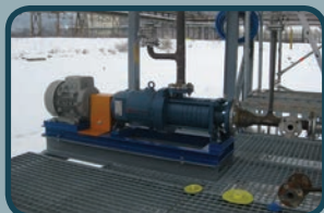
NCHZ a.s., ПЕРЕКАЧИВАНИЕ ПРОПИЛЕНОКСИДУ, НАСОСНЫЙ АГРЕГАТ ТИПА SMM С МАГНИТНОЙ МУФТОЙ
