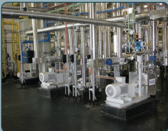
PREOL a.s., ПРОИЗВОДСТВО МЕНО, НАСОСНЫЕ АГРЕГАТЫ ТИПА CSI С ОБОГРЕВОМ
