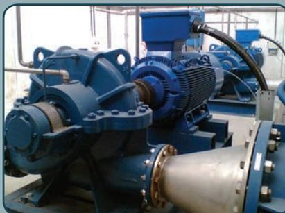
PRAŽSKÉ VODOVODY A KANALIZACE a.s., MAIN PUMPS OF THE PUMPING STATION LIBEŇ, PUMP UNITS CDS SERIES WITH 315 KW MOTORS
