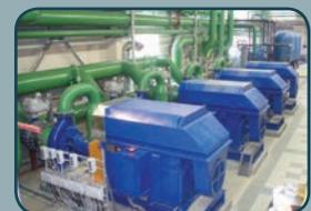
ИЖОРСКИЙ ЗАВОД [РОССИЯ], ОХЛАЖДАЮЩАЯ СЕТЬ, АГРЕГАТЫ ТИПА CSE С ЭЛЕКТРОДВИГАТЕЛЕМ 315 KW, 6000 V
