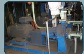
VÍTKOVICE a.s., ПОДВЫШКА НАПОРА В ПРОЦЕССЕ НА 80 БАР, НАСОСНЫЙ АГРЕГАТ ТИПА CSA, УЛОЖЕНИЕ OG2
